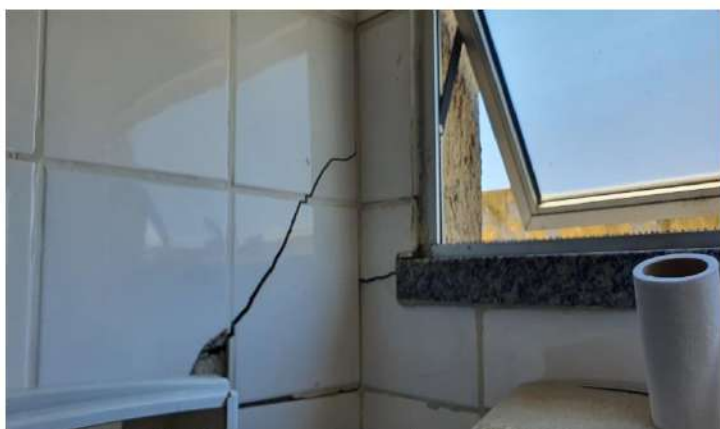
Foto 29 - Detalhe fissura par. 1 e par. interna WC Sala Coordenação
