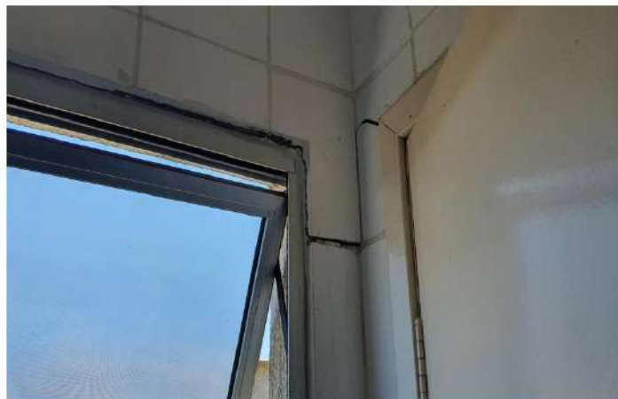
Foto 28 - Detalhe fissura no WC da Sala Coordenação - Par. 1
