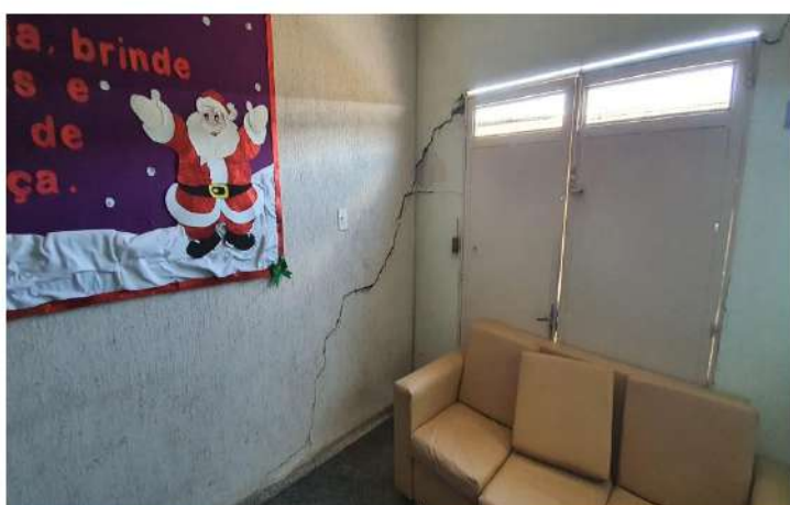
Foto 35 - Detalhe fissuras na Par. 1 e par. interna no Wall
