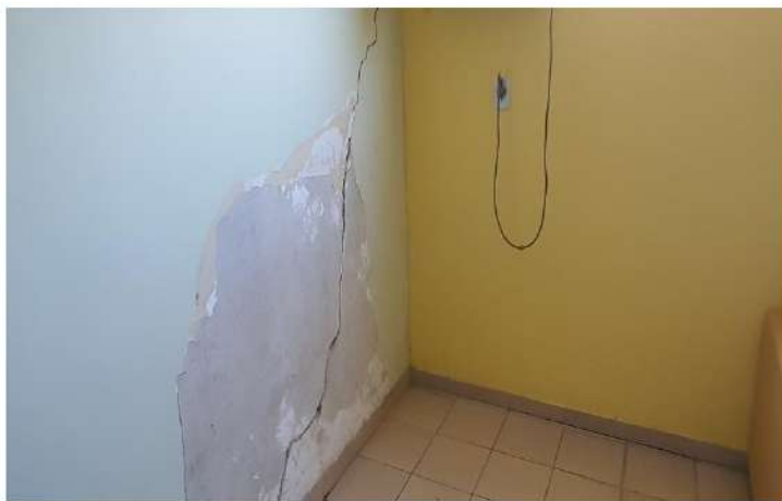
Foto 37 - Detalhe fissura parede interna Sala Educadores
