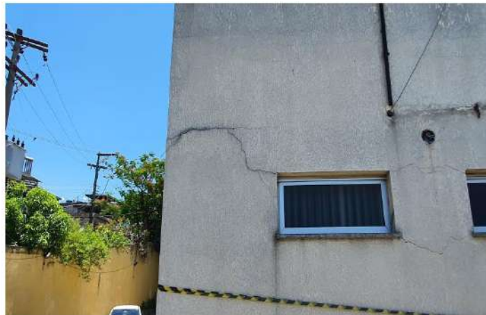
Foto 14 - Detalhes fissuras na Fachada 1
