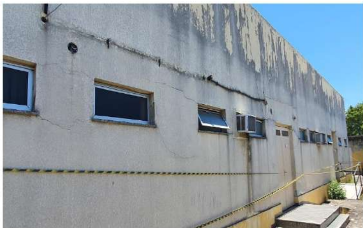
Foto 13 - Vista de diversas fissuras na Fachada 1
