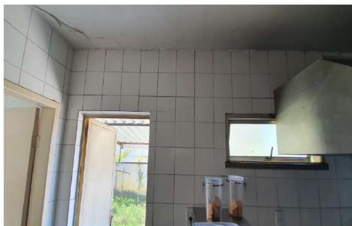
Foto 52 - Vista fissuras canto superior direito da porta cozinha
