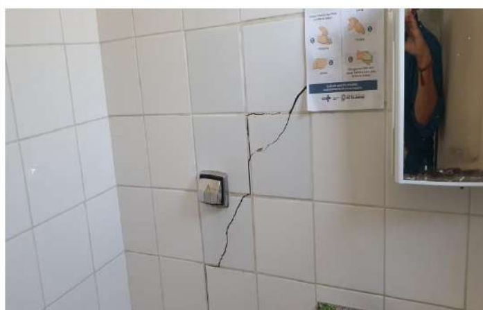
Foto 30 - Detalhe fissura WC da Sala Coordenação
