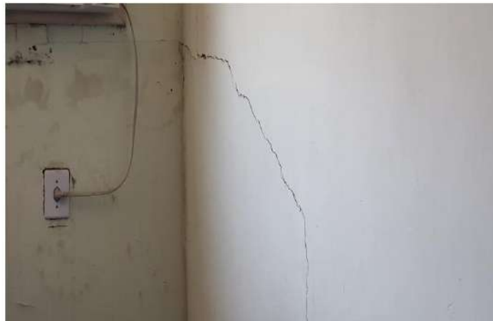
Foto 32 - Detalhe fissura par. interna Sala Recepção
