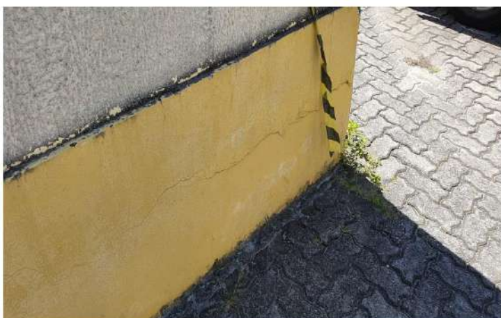
Foto 23 - Detalhe fissura no baldrame Fach. 2
