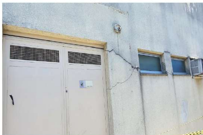
Foto 22 - Vista de mais fissuras na Fachada 1
