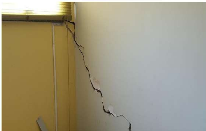
Foto 39 - Detalhe fissura Sala Educadores parede interna
