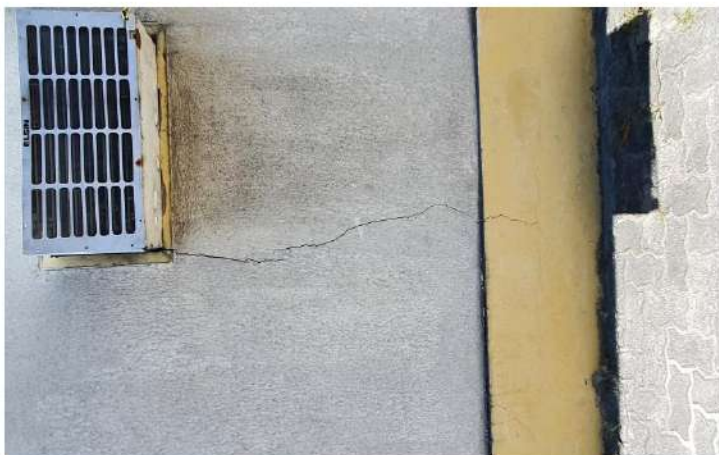
Foto 19 - Detalhe de fissuração na Fachada 1
