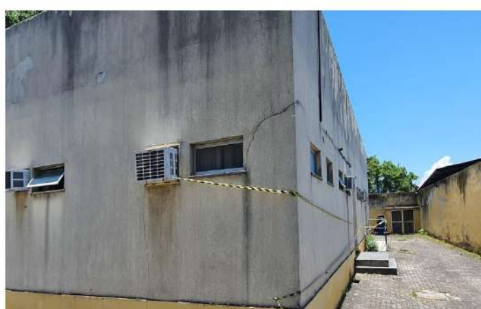
Foto 18 - Detalhes das fissuras na Fachada 2
