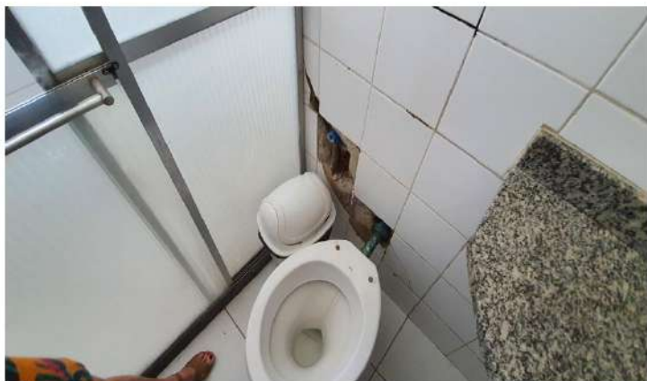
Foto 43 - Detalhe fissura parede interna banh. fem. Sala Armários
