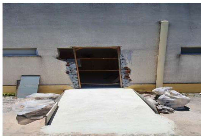
Foto 4 - Abertura para nova porta na fachada 2
