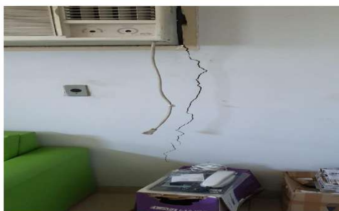
Foto 24 - Sala Coordenação. Vista interna de fissura na Fach. 2
