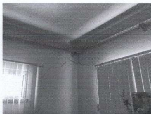
Foto 12 – Trinca horizontal entre esquadrias – localizada na coordenação
