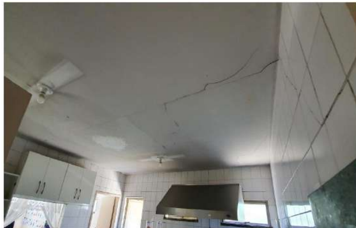
Foto 50 - Vista fissura parede e teto gesso na Cozinha
