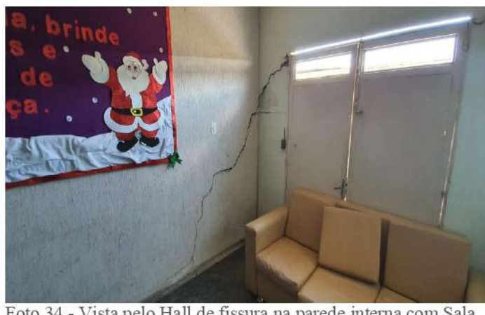
Foto 34 - Vista pelo Hall de fissura na parede interna com Sala Educadores e na parede Fach. 1
