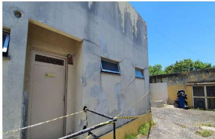
Foto 20 - Vista de fissuras na Fachada 1
