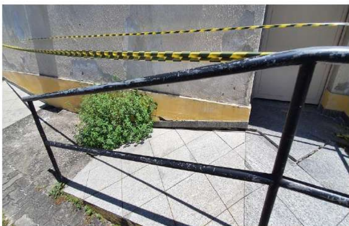
Foto 21 - Detalhe desprendimento pisos nos acessos Fac. 1
