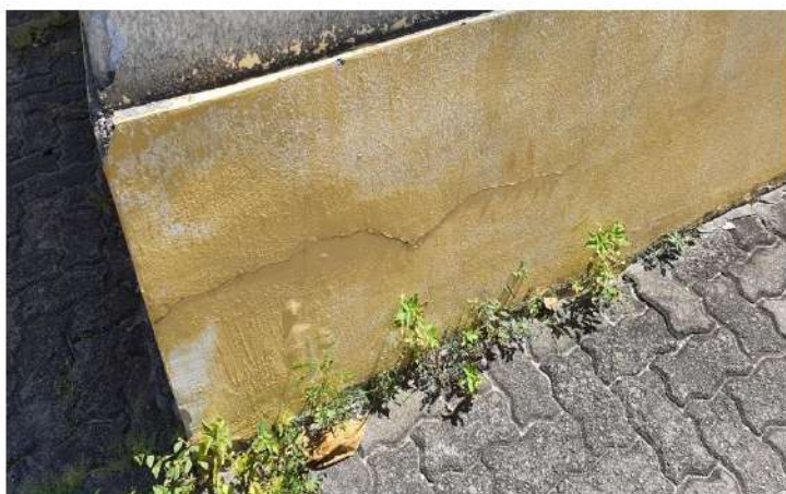
Foto 15 - Detalhe da fissura na base da Fach. 1
