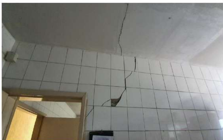
Foto 51 - Detalhe fissura parede interna entre Cozinha e Despensa
