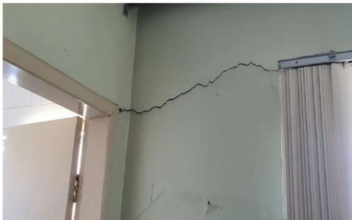
Foto 27 - Detalhe fissura junto a entrada WC da Sala Coordenação
