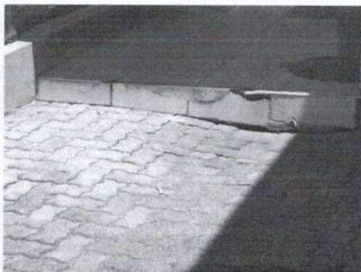
Foto 5 – Região com drenagem insuficiente – recalque do piso intertravado
