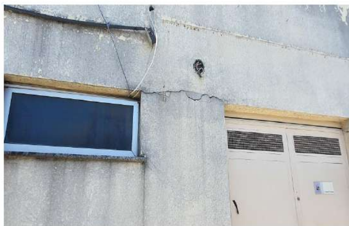
Foto 16 - Detalhe de fissura na Fachada 1
