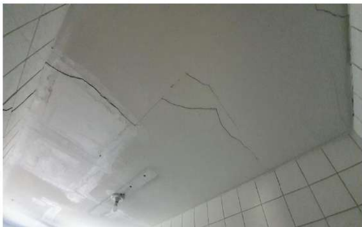
Foto 49 - Vista fissuras teto de gesso do Almojarifado
