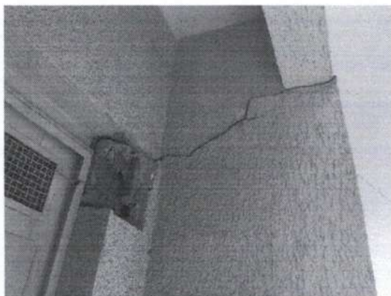
Foto 7 – Trinca localizada na fachada – trechos de alvenarias desconectadas
