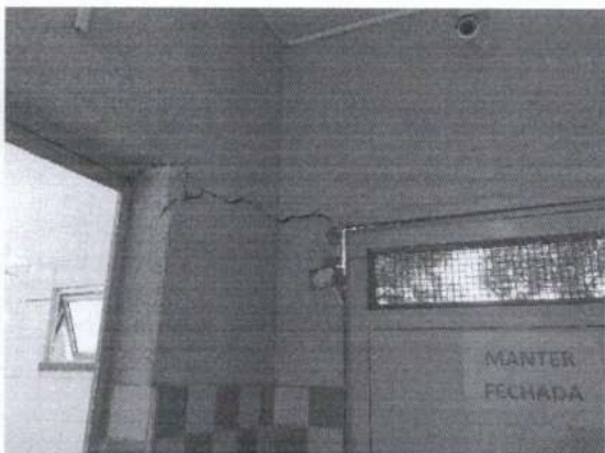
Foto 15 – Trinca horizontal localizada entre as aberturas – trechos de alvenarias desconectadas
